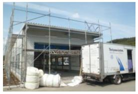
工場と云えば鉄骨造でスレートの波板の屋根・壁が定番でし た、最近はほとんど折版屋根に壁もガルバーなどの金属製に なりました、そうですアルミに次いで熱を通す建材です。 つまり結露を起こしやすく、音も反射します。金属製の折版 には結露防止のペフ材を貼り付けますが、あくまで結露防止 しかし 10 年もすると部分的に剥がれ、そこに結露が集中し て剥がれがひどくなることが多いのです。
