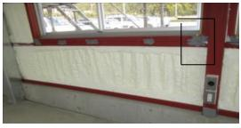
鉄骨の場合外部の仕上げ材と接する 溝形鋼が熱橋となりますが、繊維系と 違いフォームの充填は可能です、しか し左拡大写真のような窓納まりでは どうしようもありません、次回サーモ グラフィー写真で検証いたします。
