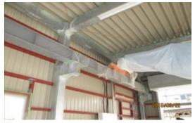
折版の金属面に直接アイシネンを吹き付けることで結露を 防止し屋根からの暑さ・寒さを遮断します、また大雨の場合 金属面に当たる雨音が反響してうるさく、話が出来ないほど ですが、アイシネンの吸音性から室内もかなり静かです、そ して何より自己接着性から剥がれ落ちることがありません。 (柱・梁など露出部は全て時間をかけて養生しました)
